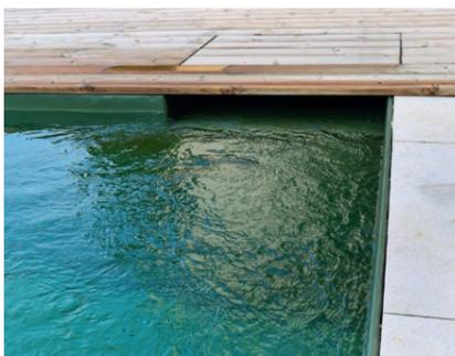
Unter dem Holzdeck aus Fichte befindet sich der Schwimmkörper. Hier wird das Oberflächenwasser zuerst von größeren Verschmutzungen gereinigt und anschließend in den Filterkreislauf geleitet.
